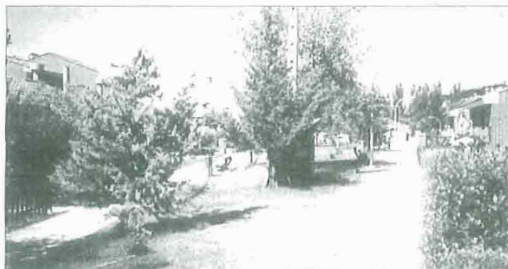
Las nuevas viviendas unifamiliares de La Llana tendrán una fisonomía parecida a las que ya están construidas.
