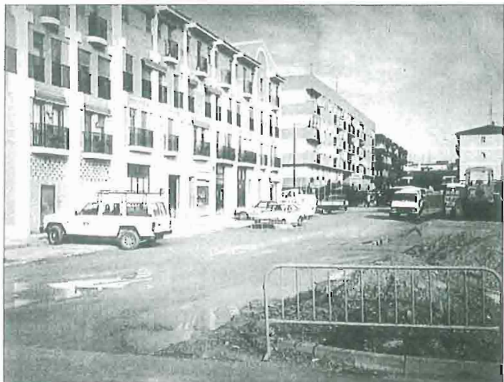
Obras de pavimentación en la calle Blas Berni.
