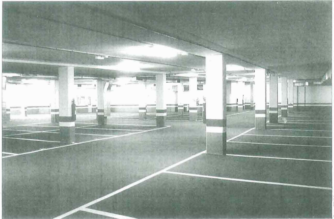
Vista interior de los aparcamientos.
