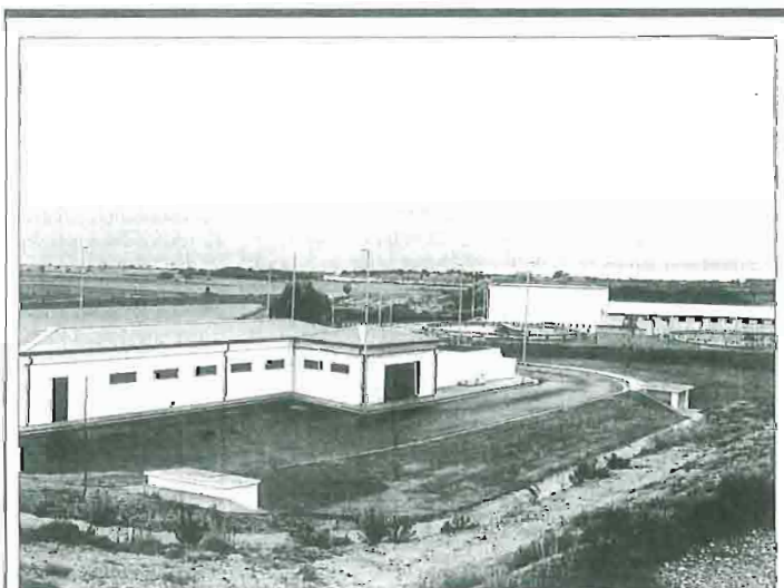
Planta potabilizadora de Camarales.
