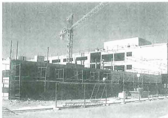
Obras de la Residencia de Mayores.
