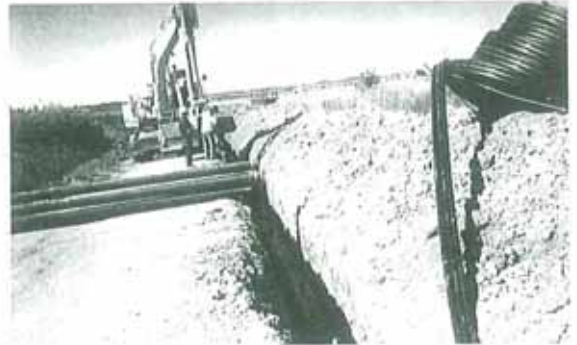
Obras del abastecimiento de agua a los Barrios de Colonización.
