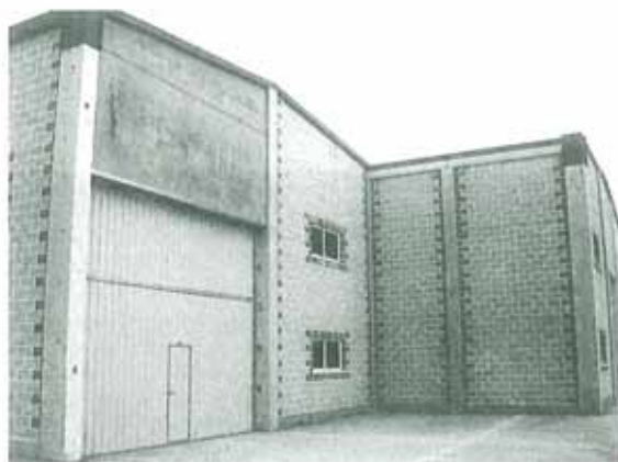
Nave industrial donde se ubicará Electrojea.
