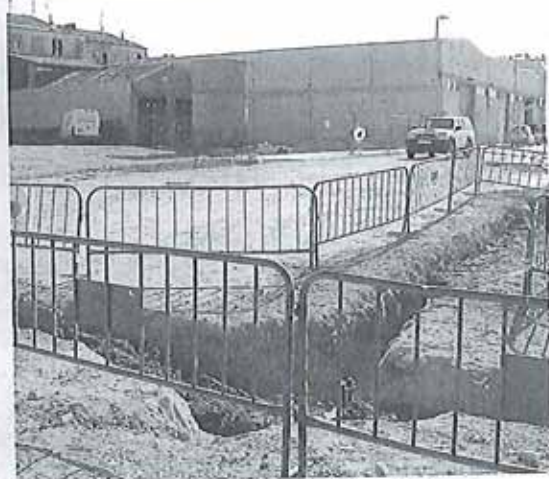
Obras en la Calle Ronda del Ferrocarril.
