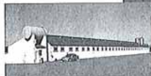
NAVE DE PORCINO
