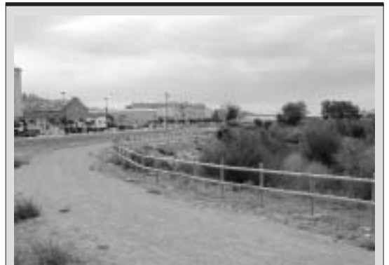
Las obras del Parque de la Estación intervendrán sobre el tramo del río Arba de Luesia que discurre entre los dos puentes del antiguo ferrocarril y que va paralelo a la calle Ronda del Ferrocarril. Allí se harán diversas intervenciones medioambientales en las riberas y se acondicionará un paseo paralelo al río, para el disfrute de todos los ciudadanos. El Parque de la Estación da continuidad al Cinturón Verde de Ejea que viene desde el Parque Central y salta la carretera de Tauste hacia el nuevo parque que hay junto al Puente de la Vía.
