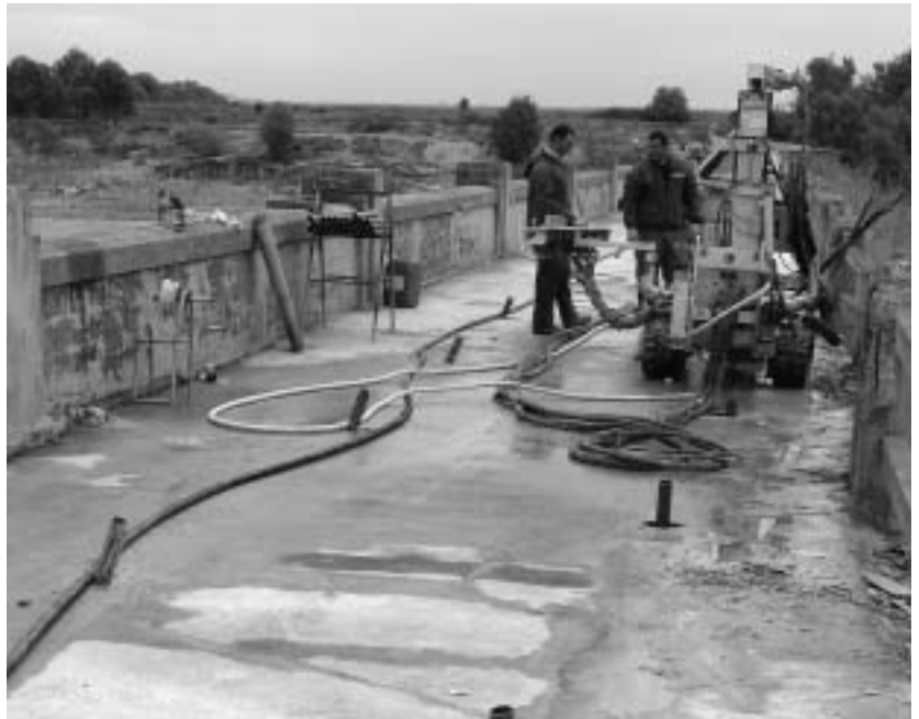
La segunda fase de las obras de San Bartolomé consisten en el pilotaje de la presa del embalse. En ella se está inyectando hormigón para consolidar su estructura y evitar que en el futuro se produzcan nuevos problemas. La intención de la CHE es solucionar de forma definitiva los problemas estructurales de San Bartolomé. De él depende el riego de numerosas hectáreas y el abastecimiento de agua de boca para Ejea.
