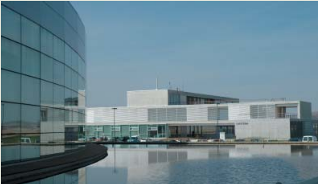
La Fundación para el Desarrollo de las Nuevas Tecnologías del Hidrógeno en Aragón tiene su sede en el Parque Tecnológico Walqa de Huesca.
