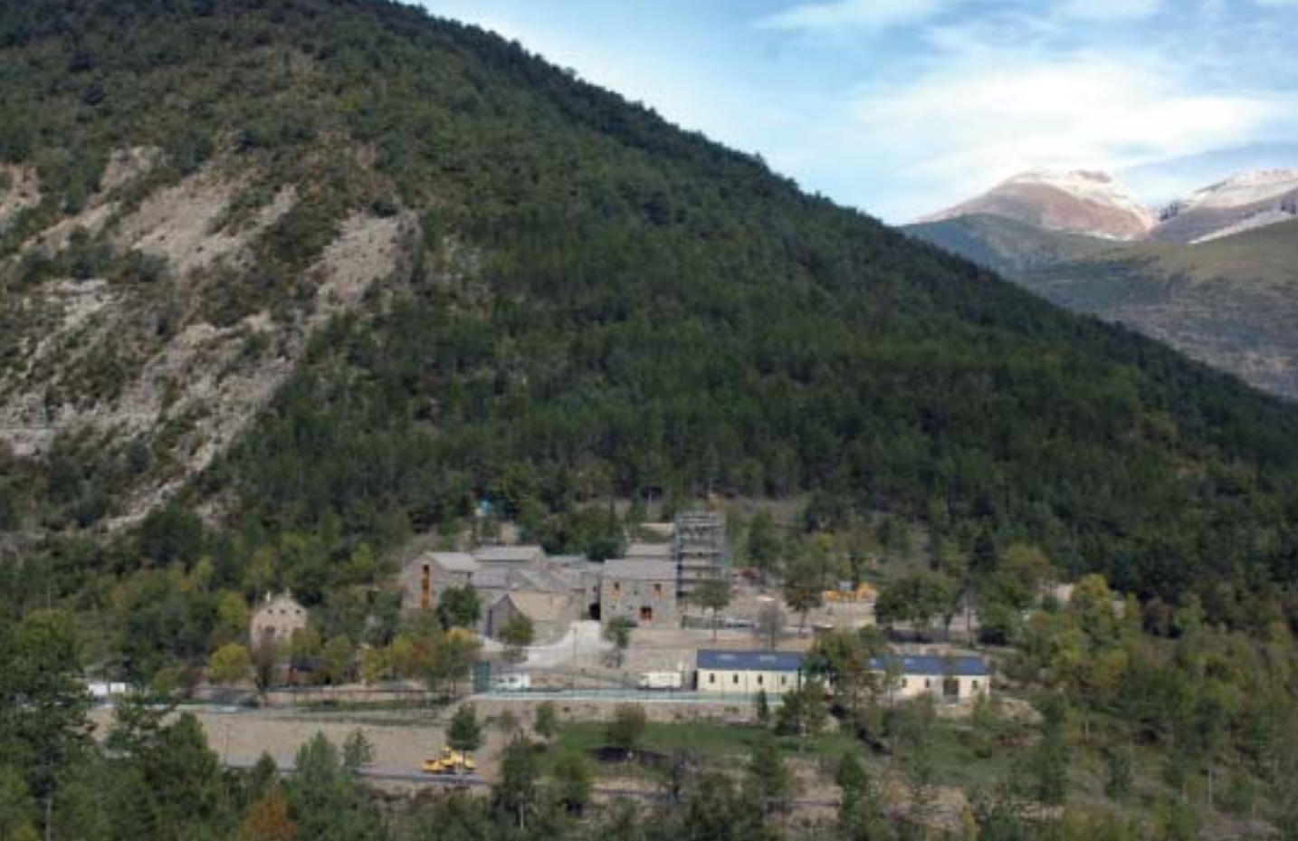
En el año 2000, la Fundación Benito Ardid, dedicada a la atención a personas con discapacidad, emprendió un ambicioso proyecto: rehabilitar y acondicionar el núcleo deshabitado de Isín.
