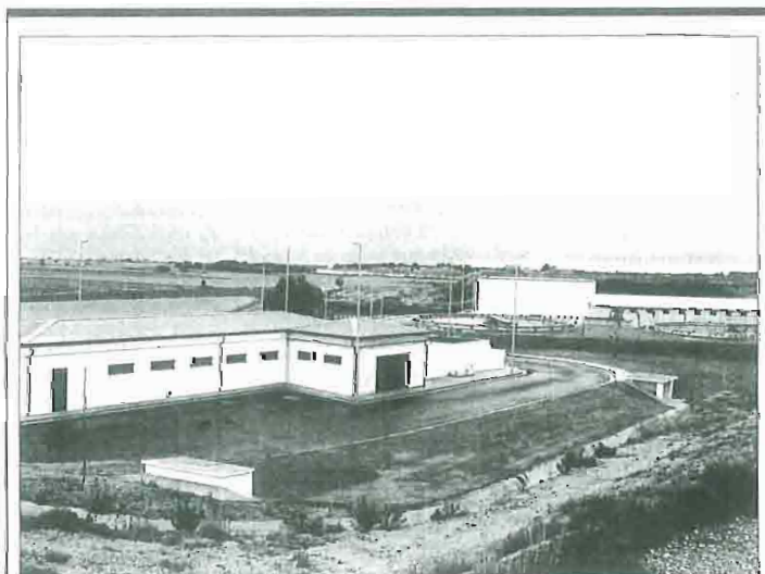
Planta potabilizadora de Camarales.
