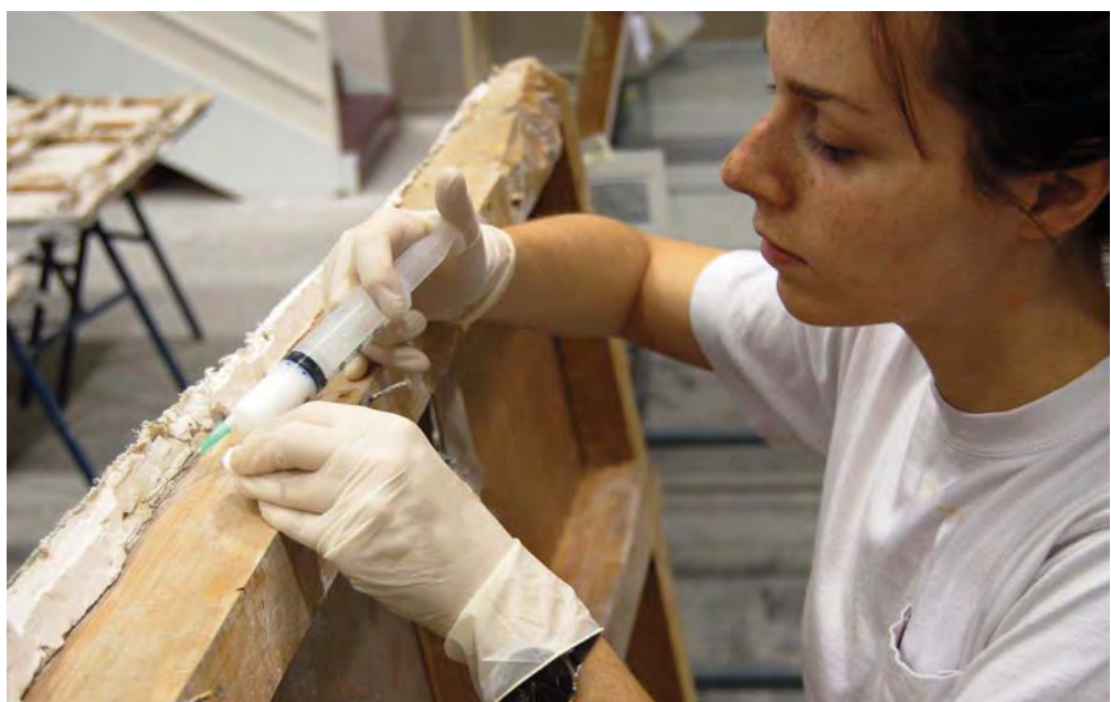
Consolidación de los bordes en los paneles de tablex
