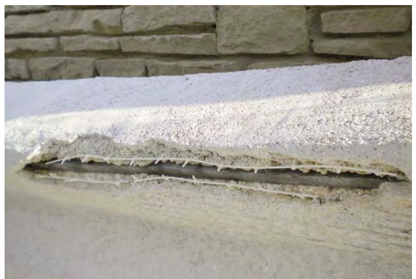
Estructura de varillas de fibra de vidrio que permite la sujeción del mortero
