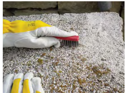
Proceso de cepillado para la eliminación de los líquenes
