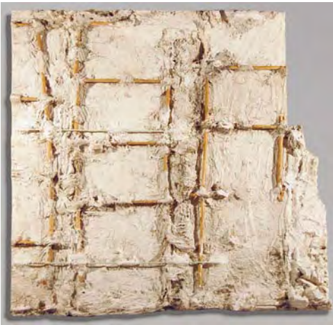
Reverso del panel 4 de yeso formado por dos placas y media con su correspondiente estructura de cañas
