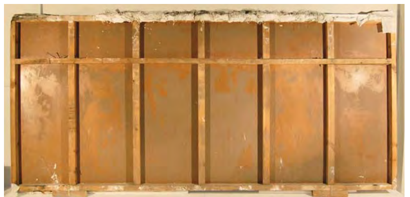
Reverso del panel 7 de táblex. Se observa el bastidor de refuerzo y los añadidos de yeso y estopa en las partes superior e inferior.
