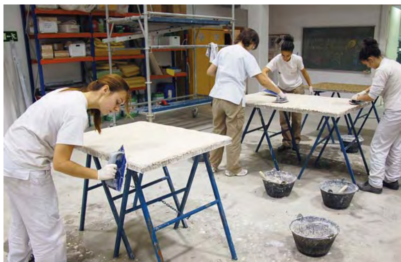
Aplicación del segundo enfoscado
