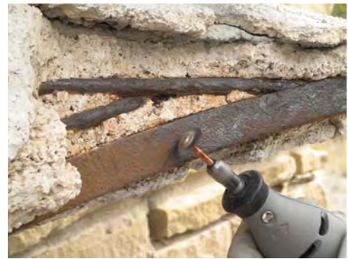
Eliminación con microtomo de la corrosión de la estructura
