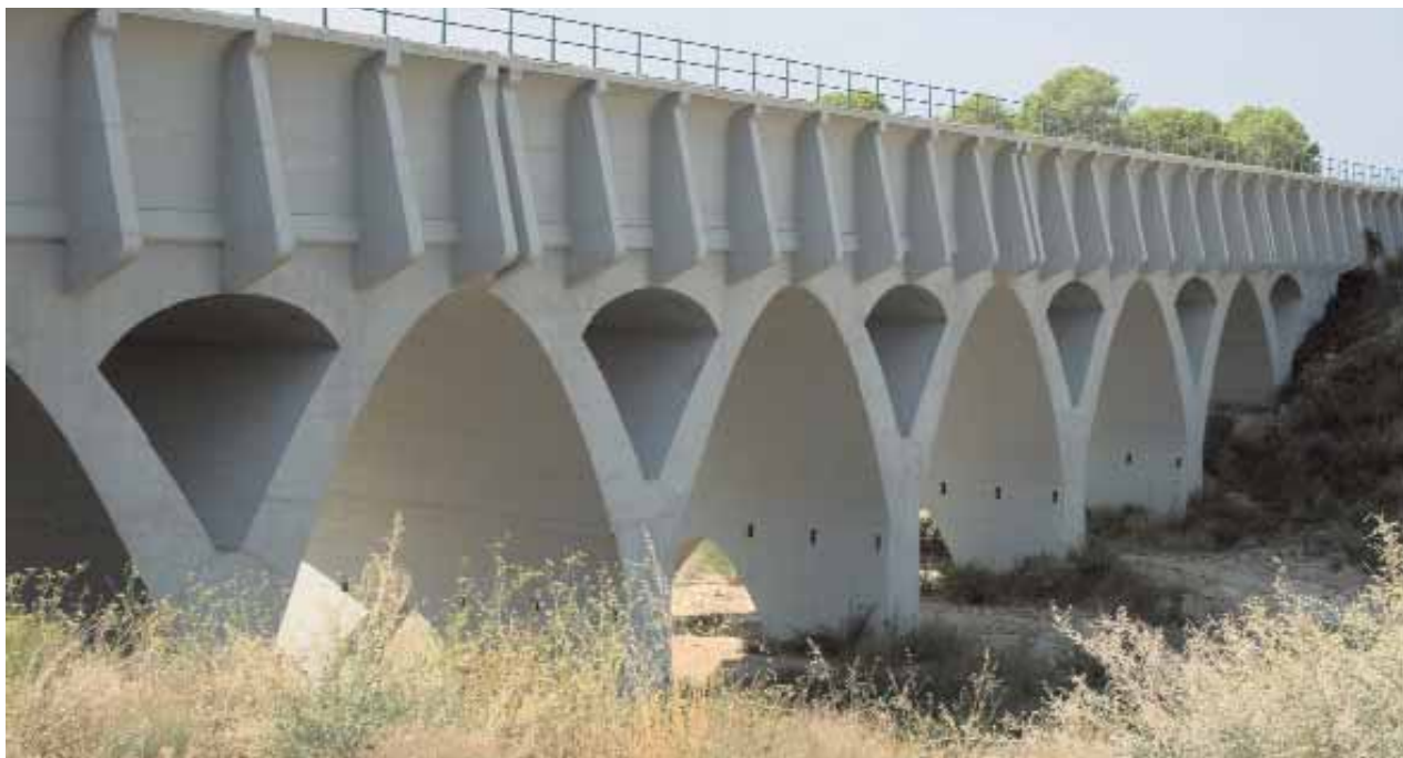
Acueducto en el Canal de Tardienta.
