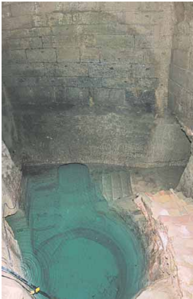
Montaje fotográfico del vaso del pozo de Laluenga . Se abastece mediante tres galerías radiales y a distinta cota.
