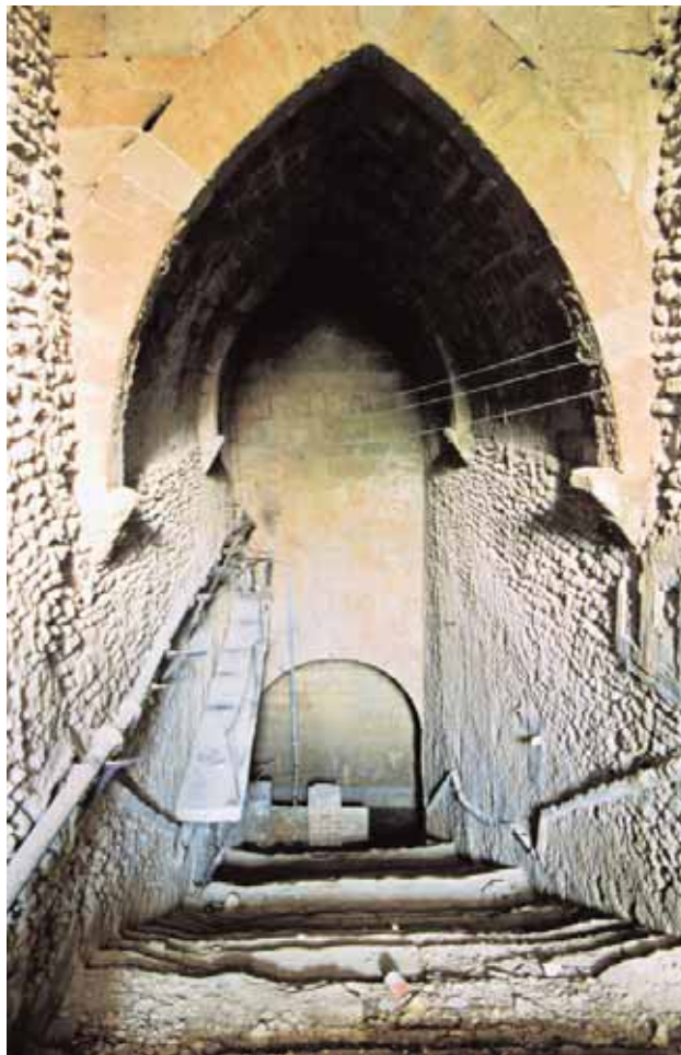
Espectacular acceso al pozo de Laluenga antes de su restauración.
