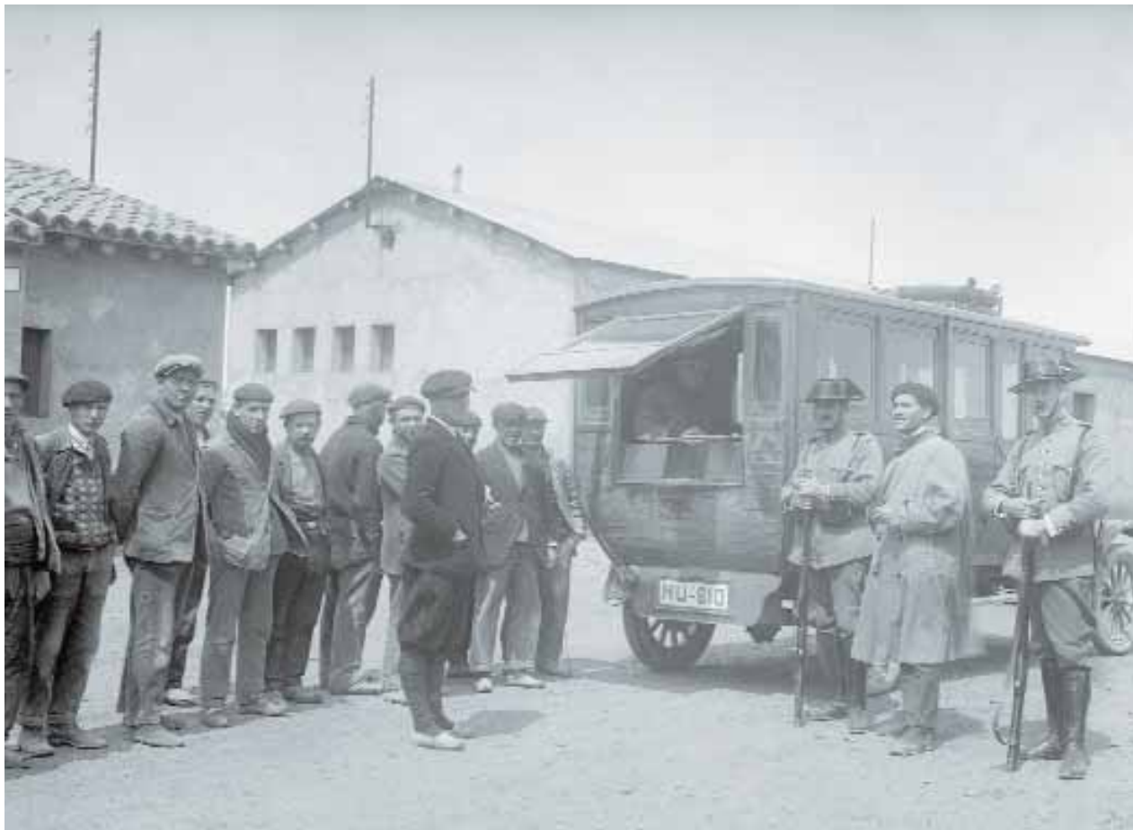
Pago a los obreros. Abajo, presa durante la construcción a finales de los años 50.
