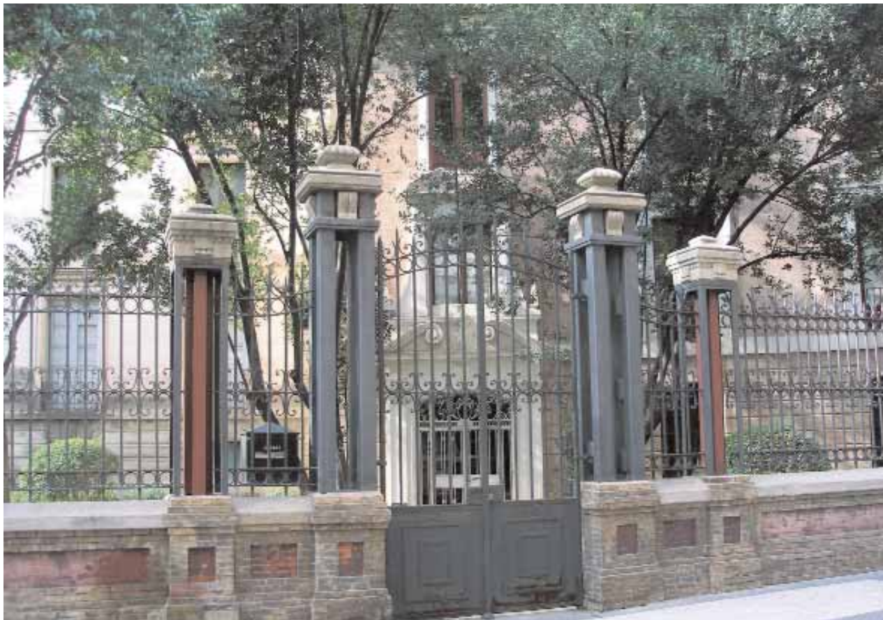
En el antiguo edificio del gobierno militar de Zaragoza, sede hoy de diversas oficinas municipales, estuvo situado el convento de carmelitas descalzas de San José, del que aún existen restos de la planta del claustro e iglesia
