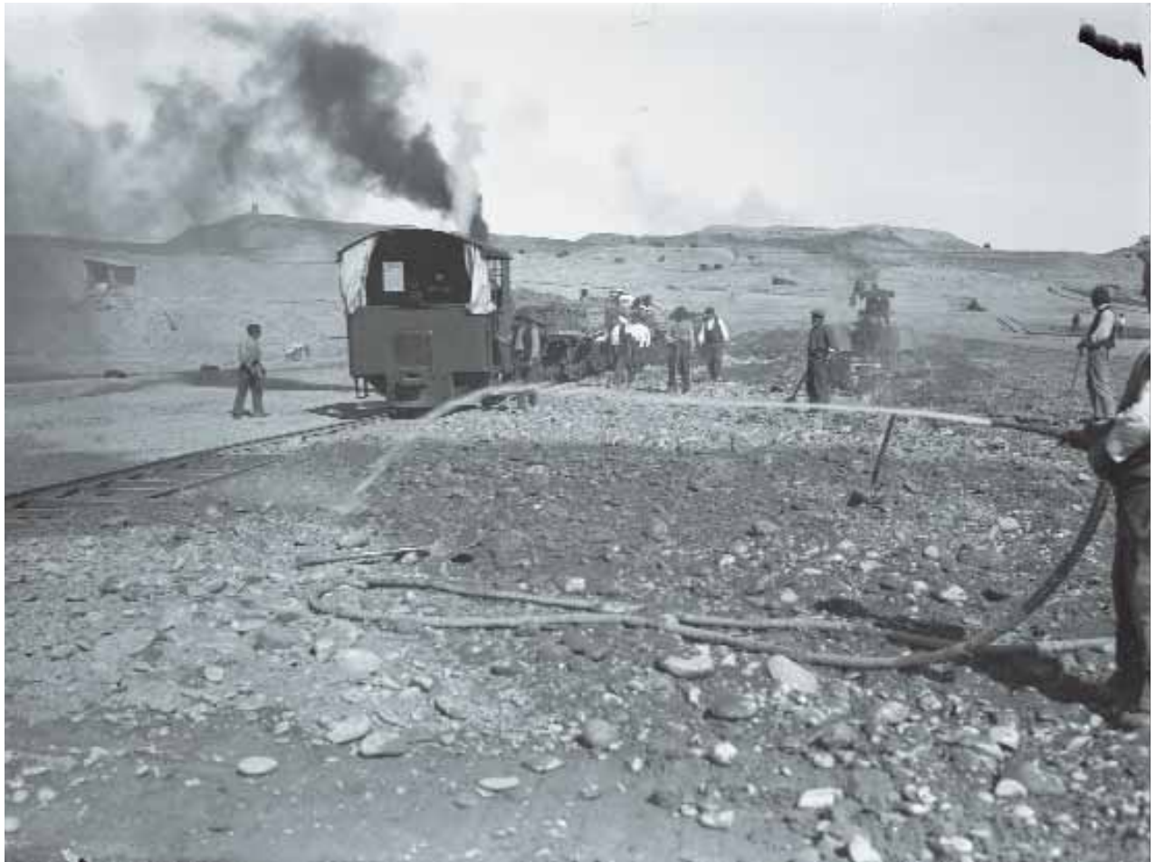
Construcción de la presa.
