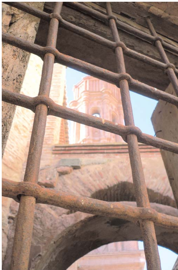
Iglesia de Plenas. Nave no cubierta.
