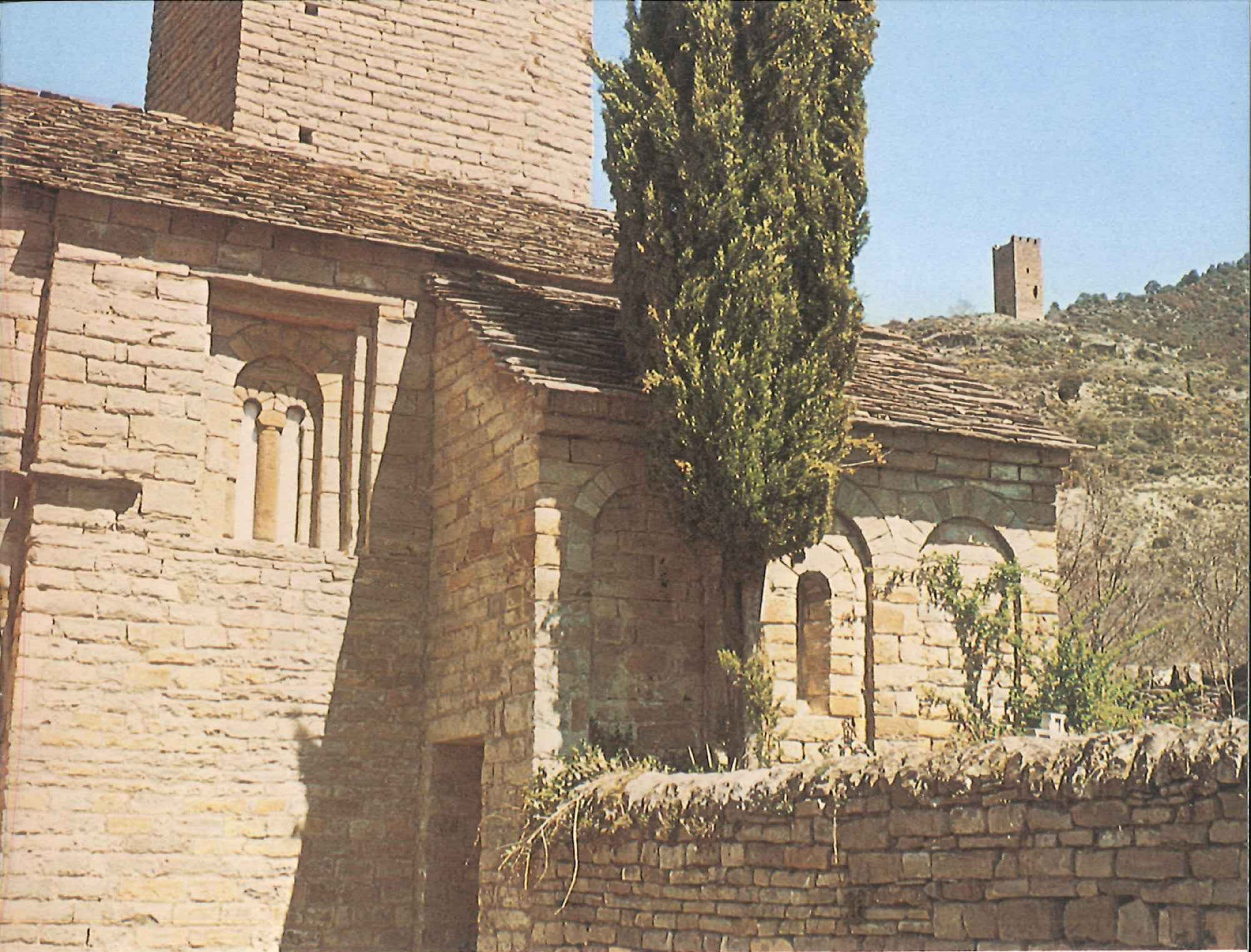
LARREDE, detalle del lateral este.
