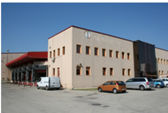
Instalaciones de Araven.
