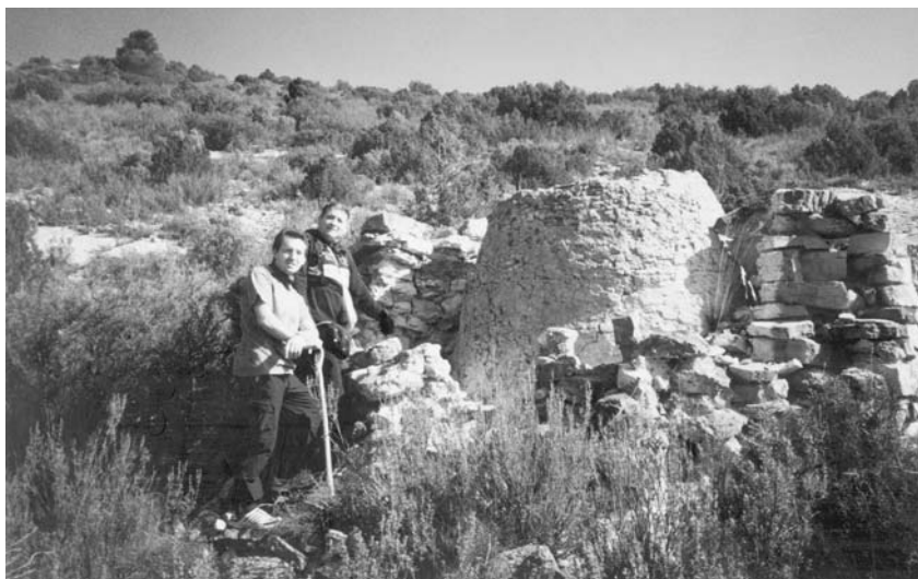
Horno de miera de Ariño. En él se pueden contemplar claramente, su forro de piedra exterior, y «la pirámide», levantada a base de trozos de teja, y forrada de barro al exterior.
