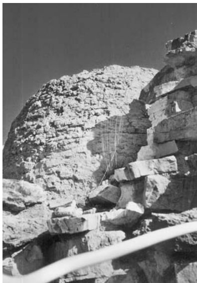
Horno de miera de Ariño. En la base del horno, un orificio de 30 centímetros de diámetro, permitía que el aire penetrara en el interior, para potenciar la ignición. También servía para destilar los litros de miera «sudados» durante la combustión, que llegaba a durar hasta 48 horas.
