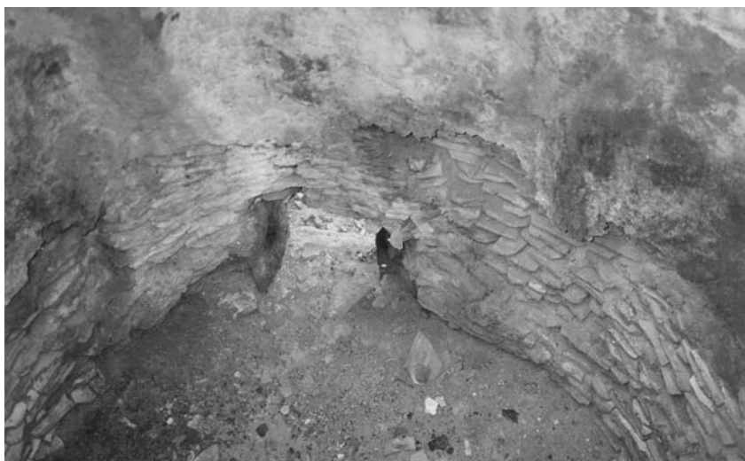
Horno de miera de Ariño. Detalle del interior de «la pirámide», en cuyo fondo aún son visibles las cenizas de la última ignición de enebro, de hace más de cincuenta años. «La pirámide», levantada con fragmentos de teja, aparece forrada de yeso al interior. El orificio que se observa, era por donde se destilaba la miera hacia el exterior.
