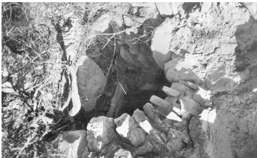
Horno de miera de Ariño. Detalle del exterior del orificio destinado a la salida de la miera destilada, y que a su vez servía como entrada de aire para favorecer la combustión.
