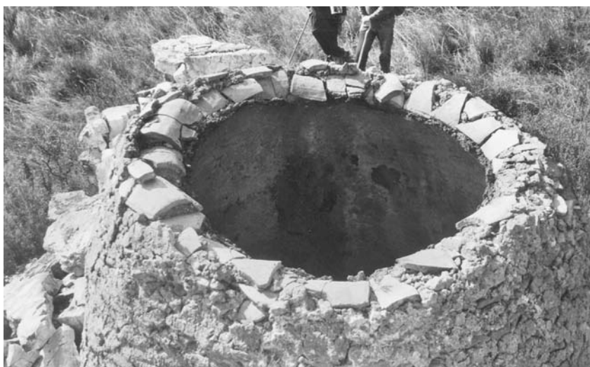
Horno de miera de Ariño. Vista cenital de «la pirámide» del horno, sellada con tejas. Su diámetro es de 50 centímetros. Durante la combustión, se tapaba con losas de piedra recubiertas de barro y paja.
