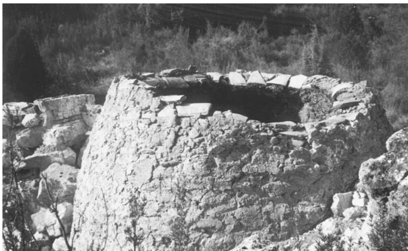
Horno de miera de Ariño. La «pirámide» del horno semeja claramente el cráter de un volcán. Su peculiar diseño favorece la combustión, y que se alcancen las necesarias altas temperaturas para que el enebro «sude» toda su savia.
