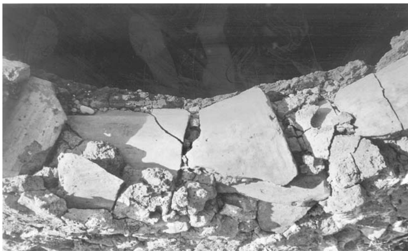
Horno de miera de Ariño. Detalle de la foto anterior, en la que se observa que el ensamble de tejas con la estructura, se hizo a base de barro y paja, con algo de cal.
