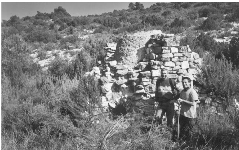
Horno de miera de Ariño. En la base del horno, un orificio de 30 centímetros de diámetro, permitía que el aire penetrara en el interior, para potenciar la ignición. También servía para destilar los litros de miera «sudados» durante la combustión, que llegaba a durar hasta 48 horas.
