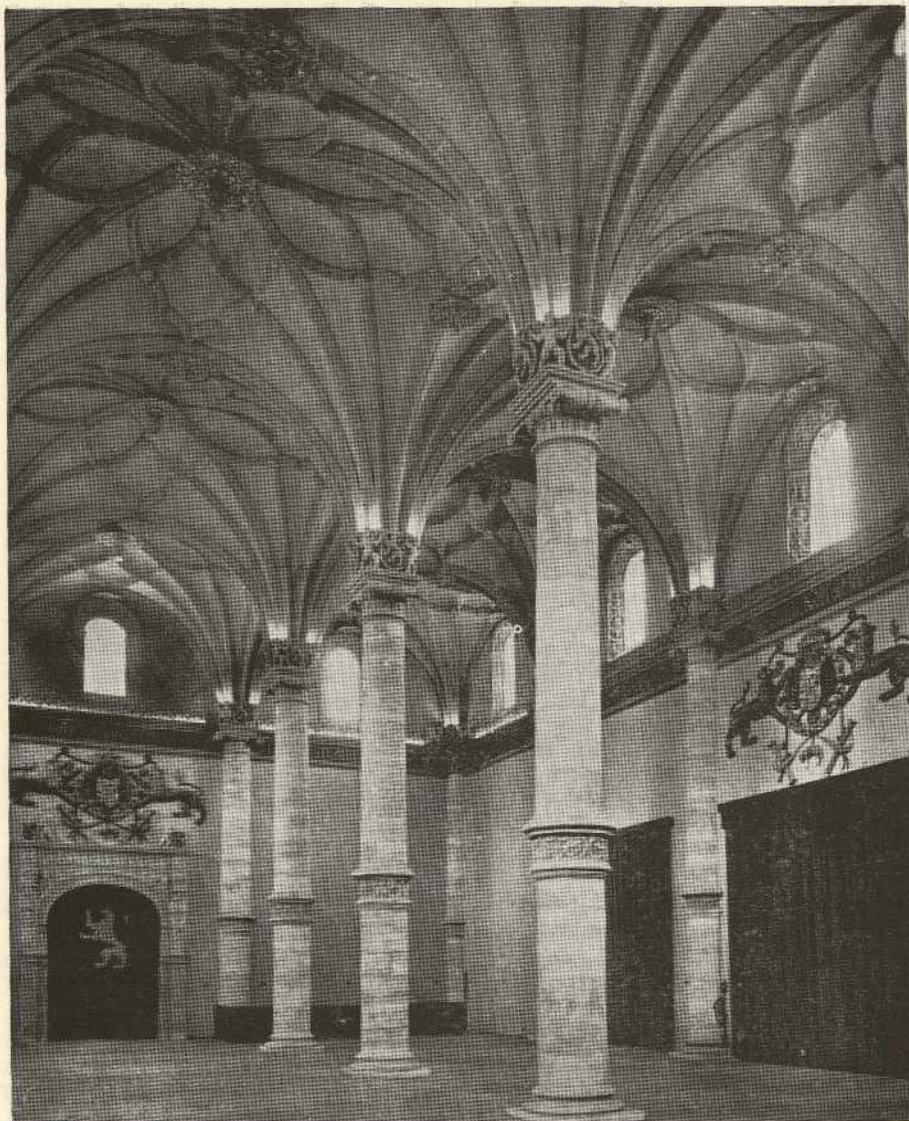
Interior de La Lonja de Zaragoza, recientemente restaurado.
