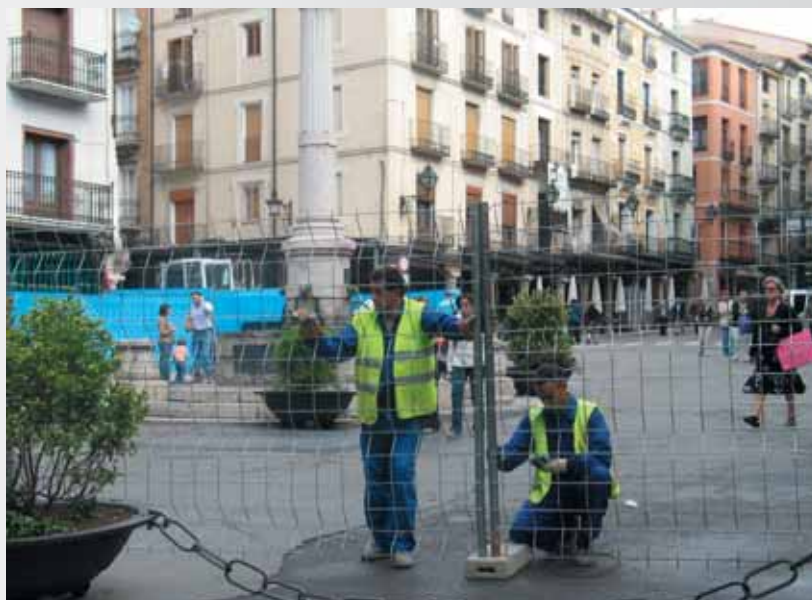
Inicio de las obras en la Plaza del Torico de Teruel.
