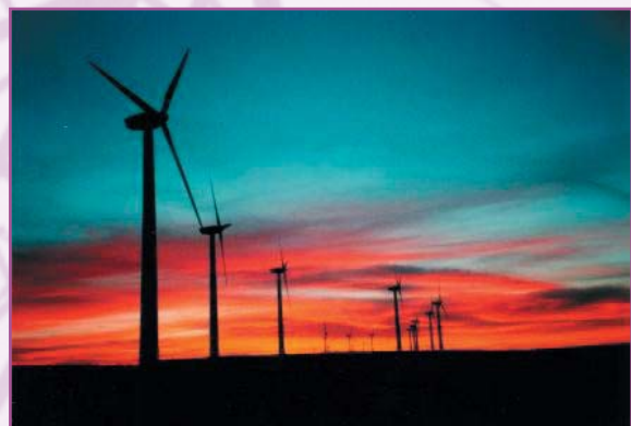
Parque Eólico Escucha. 28,38 MW (Teruel)
