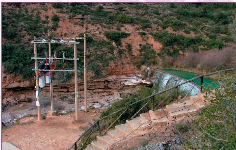
Actuación eléctrica en Bierge (Huesca).
