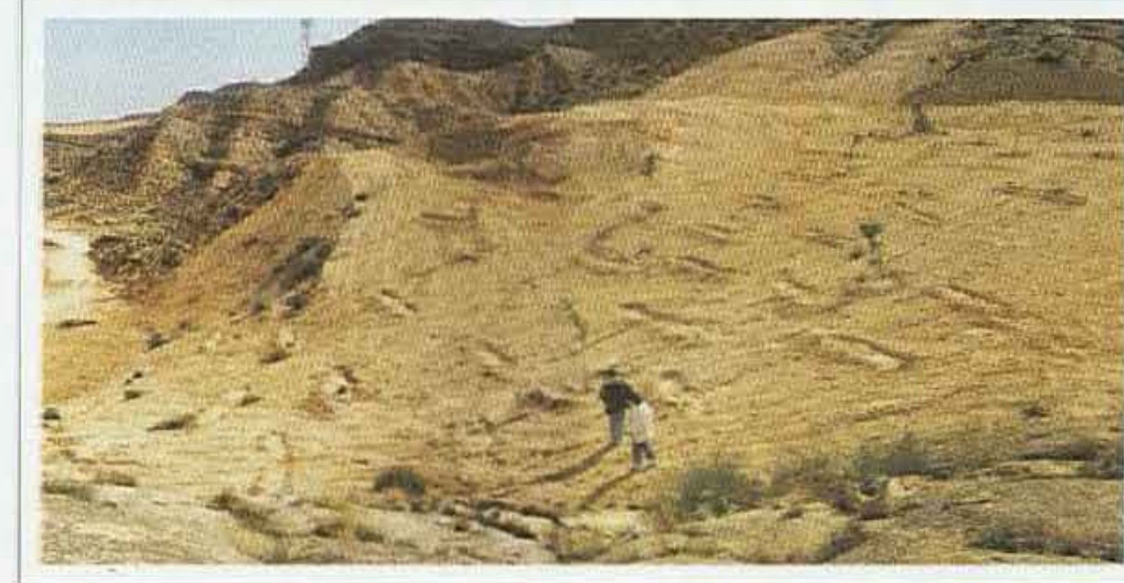
Obras de recuperación. Vertedero sellado en la Puebla de Híjar.
