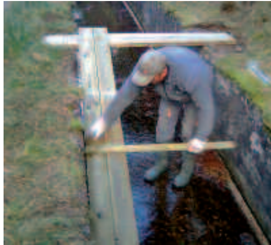
Las obras se han realizado en el canal de Morca y de Morana.
