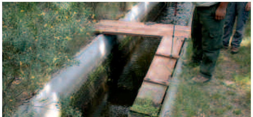
Con estas rampas se trata de crear pasos para los animales que puedan caer a los canales.
