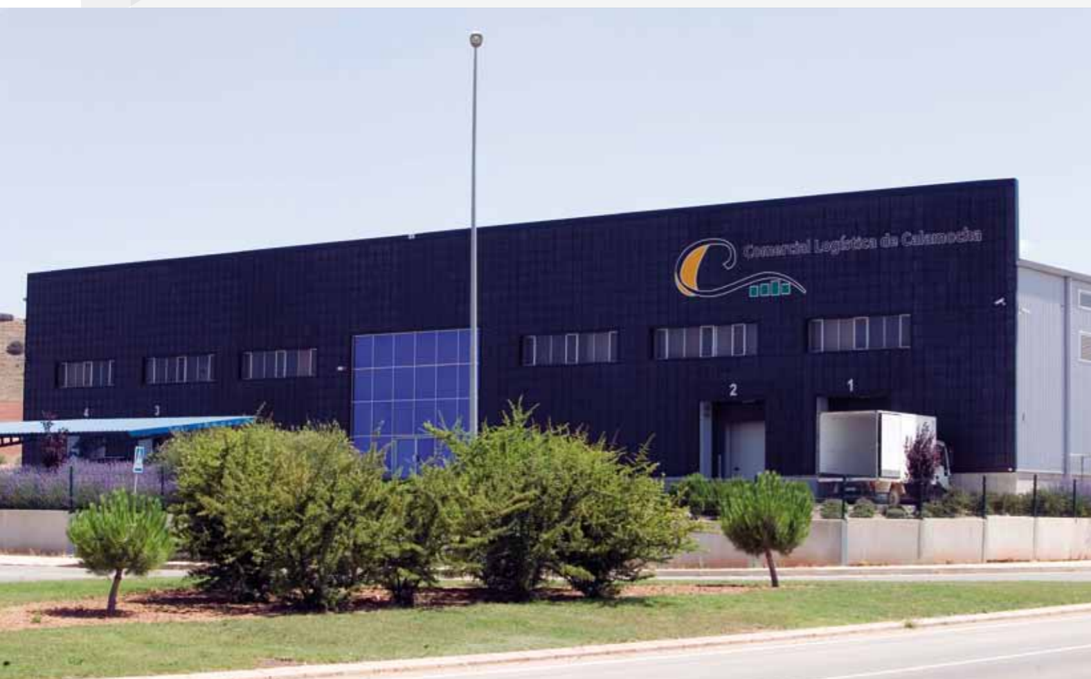
Comercial Logística Calamocha ha sido homologada para exportar a países terceros, lo que ha promovido la construcción de una nave para recibir, deshuesar, estabilizar, congelar y lonchar los jamones.
