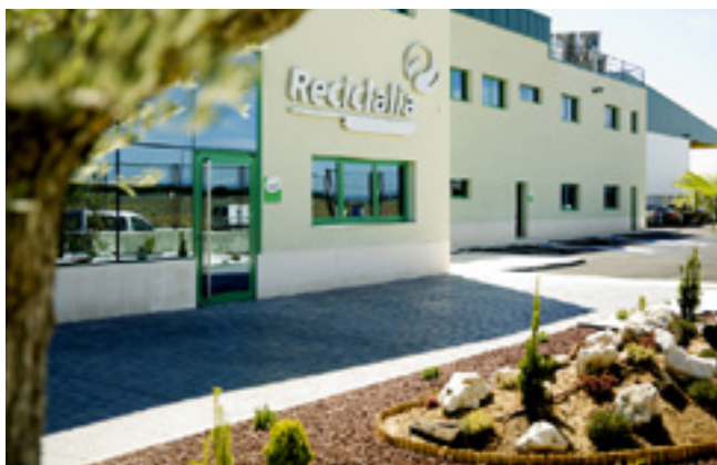
El Instalaciones exteriores e interiores de Recicjalía en La Bañeza (León)
