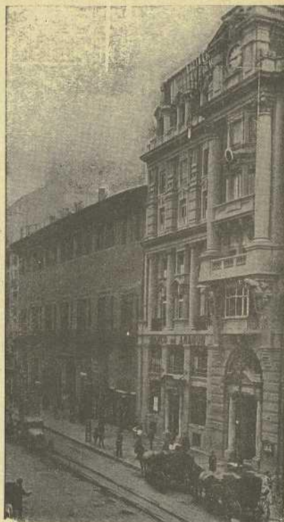
Domicilio social, COSO, 54 — Edificio propiedad del Banco
