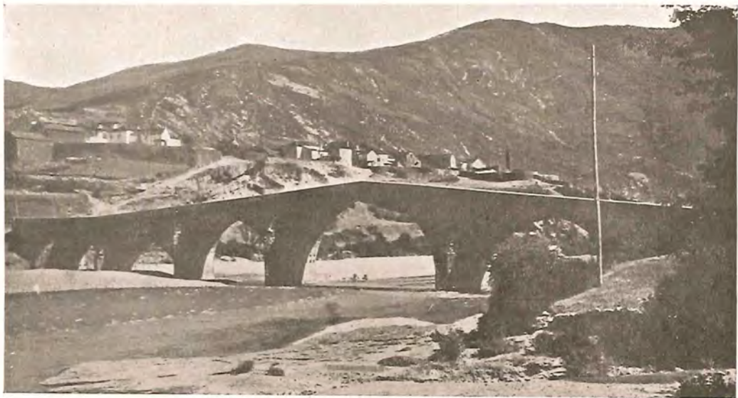
Anzánigo (Huesca): Puente sobre el río Gállego
