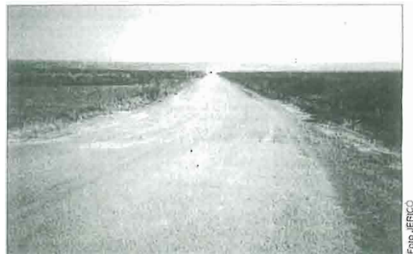
Tramo inacabado de la carretera Castejón de Valdejaesa-Ejeja.
