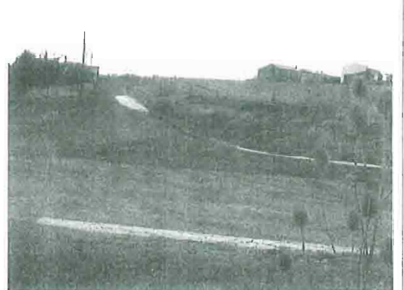
Asfaltado del acceso a Farasdués.
