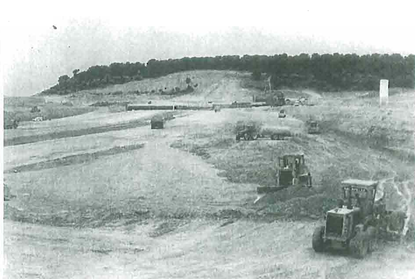
Obras en Malvecino.
