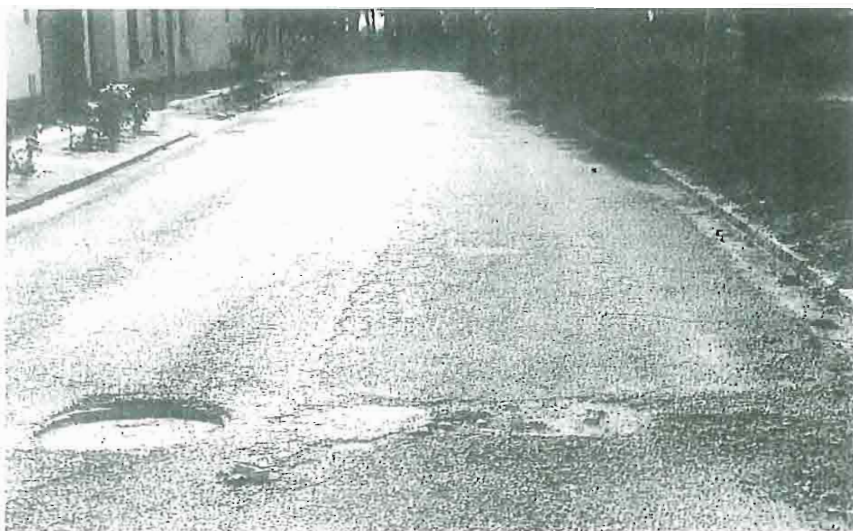
Estado de una calle del barrio de Bardena.
