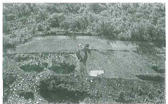
Pocas máquinas trabajando en Yesa.
