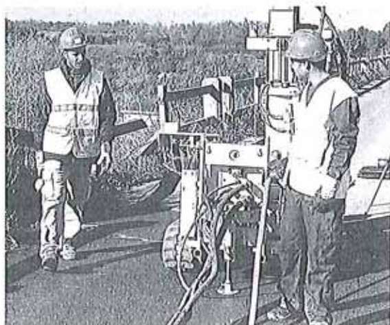
Obras en la presa de San Bartolomé.
