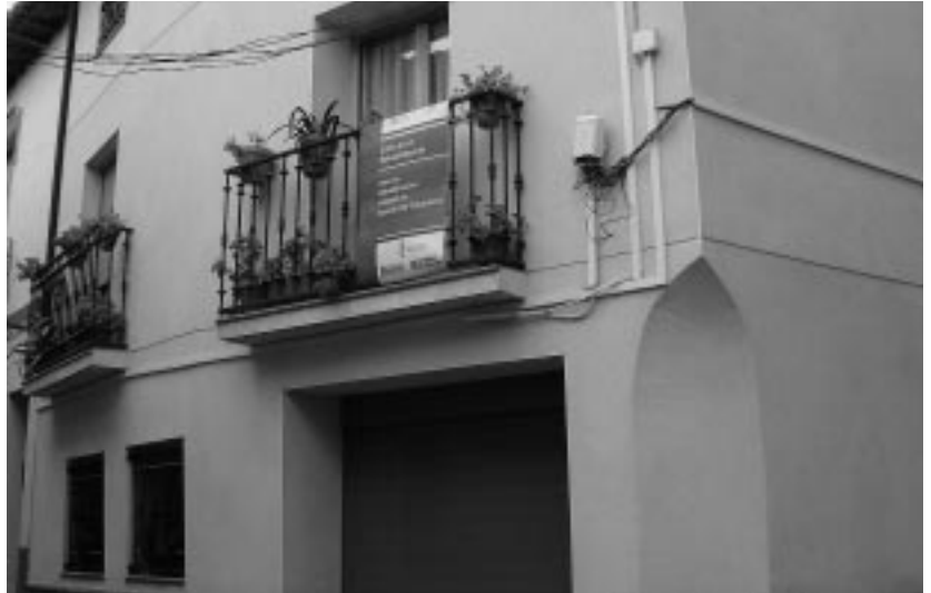
Una de las casas rehabilitadas con las ayudas del ARI.
