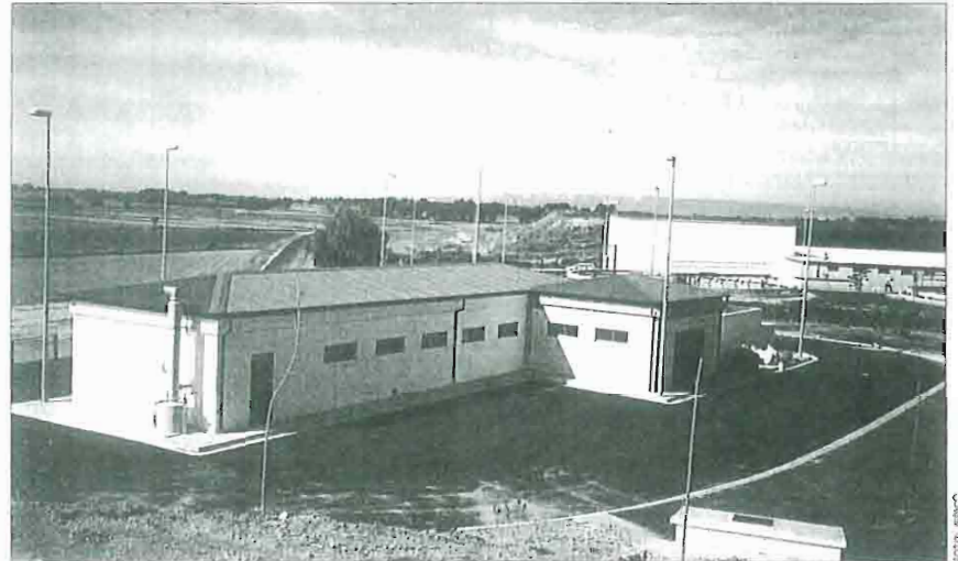
Vista general de la planta potabilizadora.
