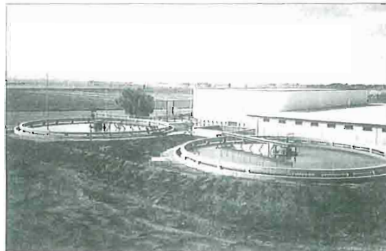
Depósitos de decantación.
