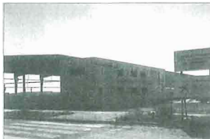
Nave de Conservas Ejea en el proceso de construcción.
