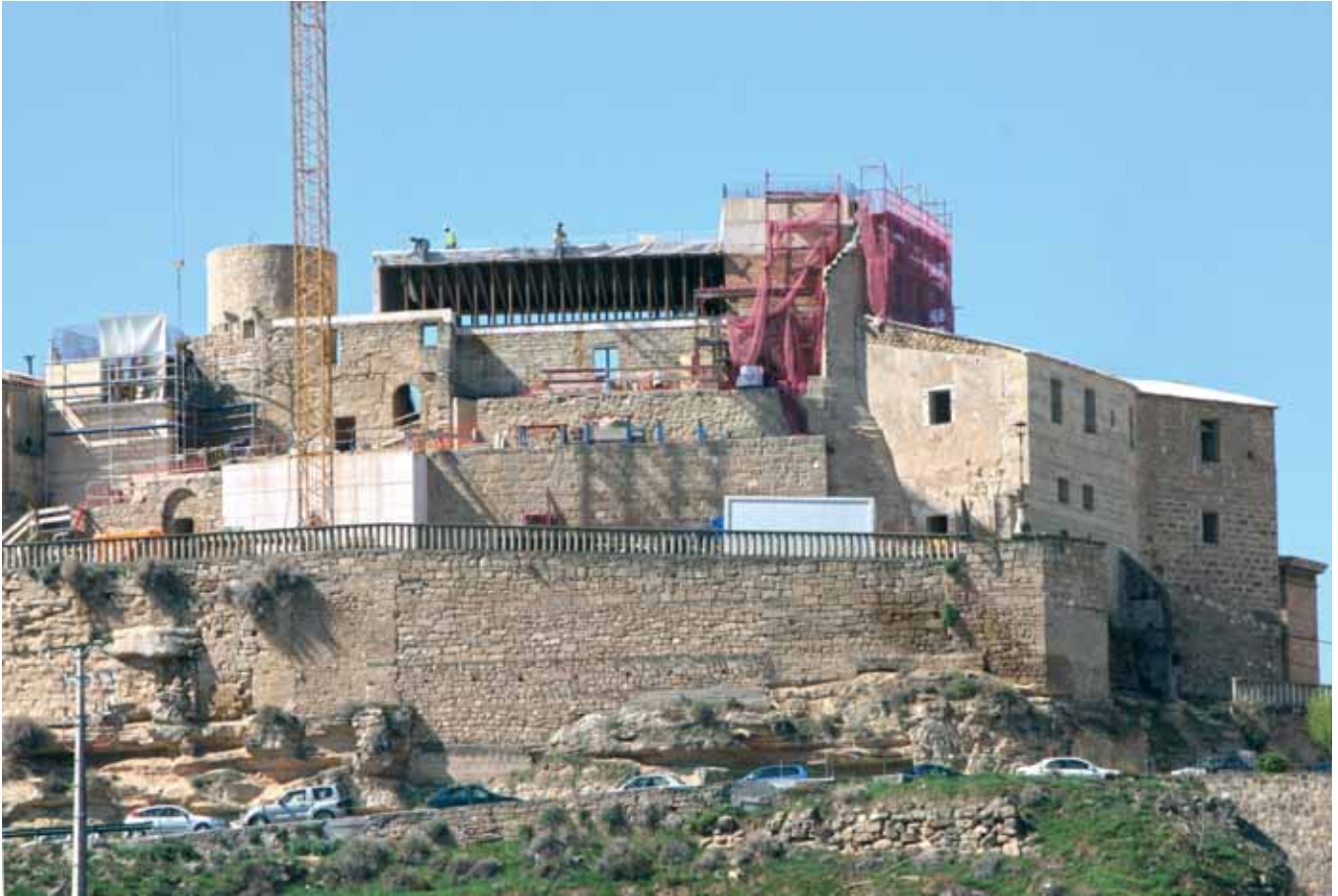
Alzado este. Fachada en obra (abril 2012).
