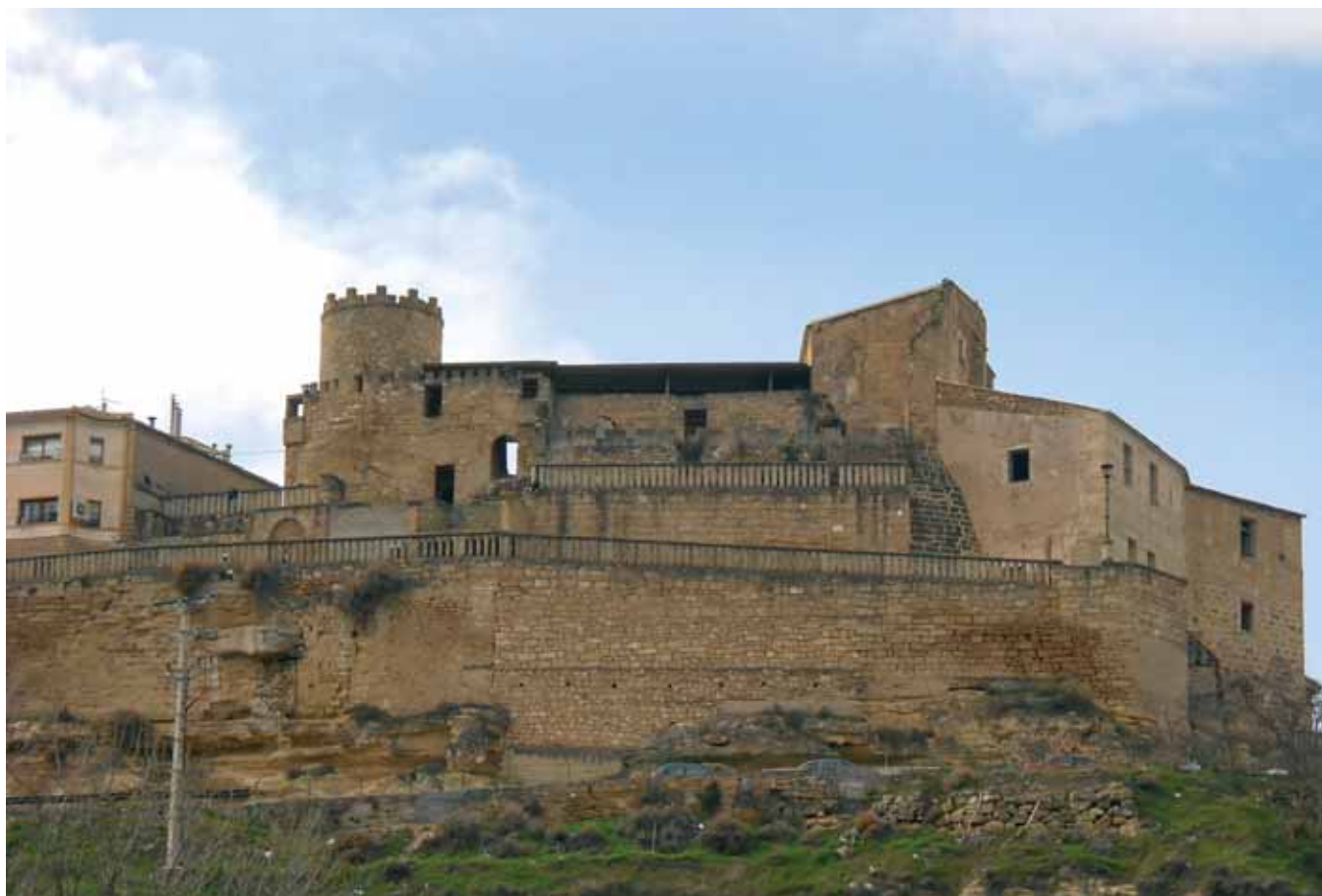
Alzado este. Fachada previa a la intervención.
