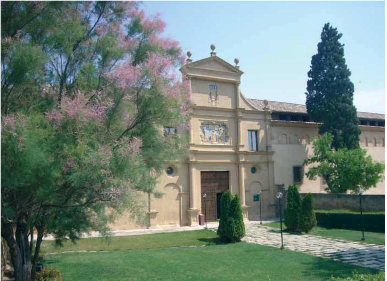
Hospedería del monasterio cisterciense del Nuestra Señora de Rueda. Está junto al Ebro, cerca de Sástago. Una de las últimas incorporaciones a la Red de Hospederías de Aragón, con rehabilitación integral del antiguo monasterio.
