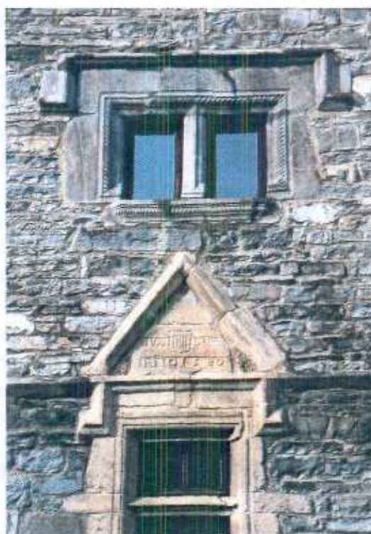
Biescas. Detalle de las ventanas de La Torraza
