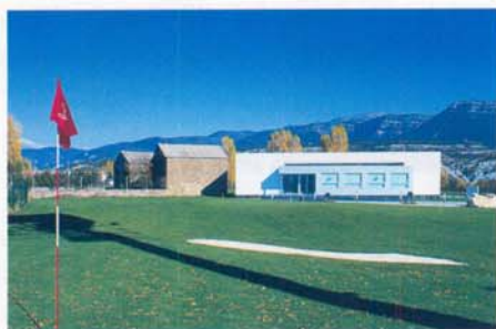
Sabiñánigo. Instalaciones del proyecto de campo de golf
