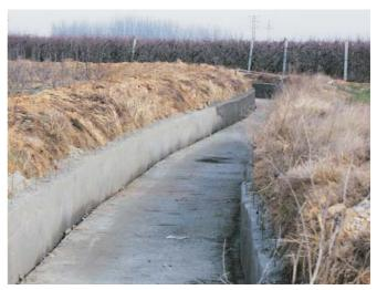
El revestimiento de las acequias se traduce en una mayor capacidad de transporte, además de una disminución de pérdidas de aqua en las conducciones.
