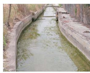
Las acequias al descubierto tienen un mayor coste en mantenimiento ya que la luz favorece la aparición de algas, las cuales dificultan el transporte del agua.
