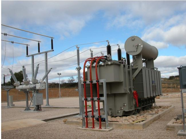
Transformador en subestación eléctrica de 20 MVA (Valderrobres, Teruel)
