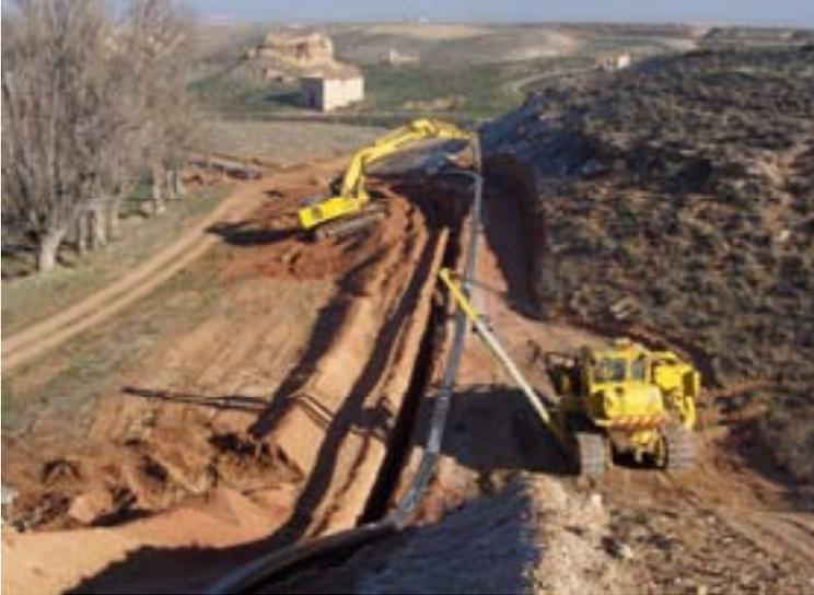
Fotografía 1. Construcción del gasoducto Cella – Calamocha.
