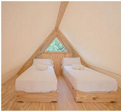
Además de la madera laminada de pino, utilizan contrachapado para el cerramiento de la fachada frontal y la trasera. Una doble lona ejerce de pared en los laterales
