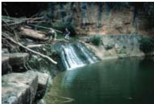
Azud en las Hoces de Torralba de los Frailes
