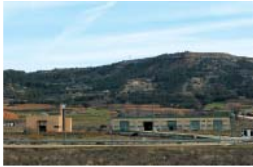
Daroca. Polígono industrial
