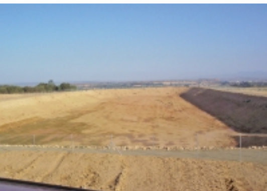
Balsa La Toma de Monzón (capacidad 100.000 m 3 ). Almacena el agua de la acequia de Valcarca, Comunidad de regantes Nuestra Señora de la Alegría
