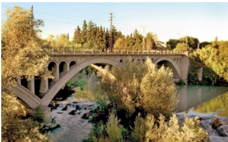
Monzón. Puente del ferrocarril sobre el río Cinca
