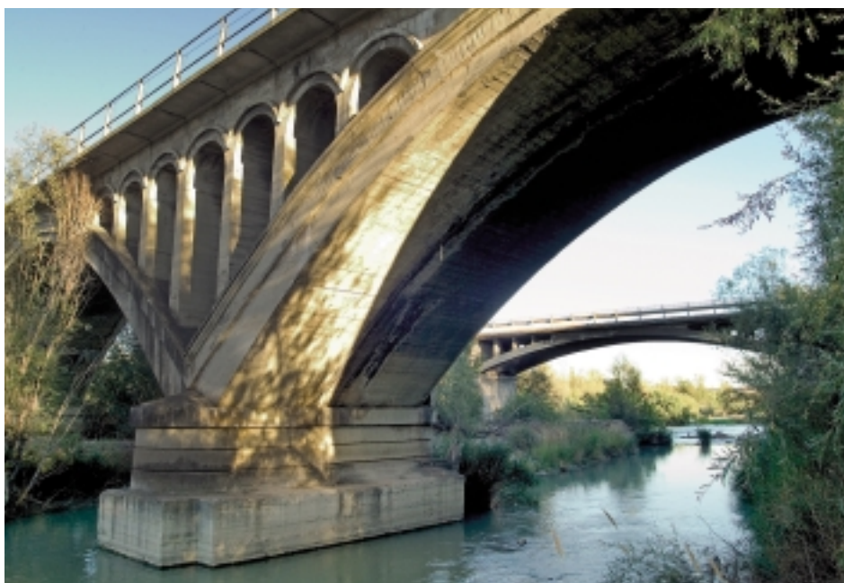
Monzón. Puentes del ferrocarril y de carretera sobre el río Cinca
