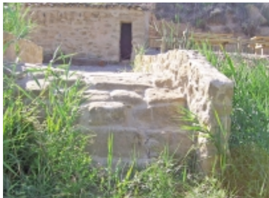
Pomar de Cinca. Puente de la barca
