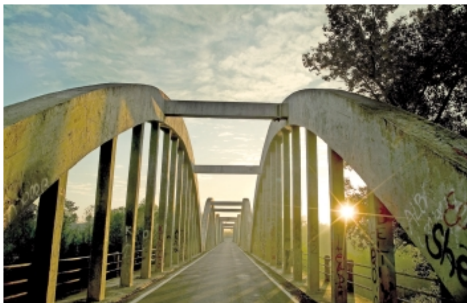
Puente de Albalate de Cinca sobre el río Cinca
