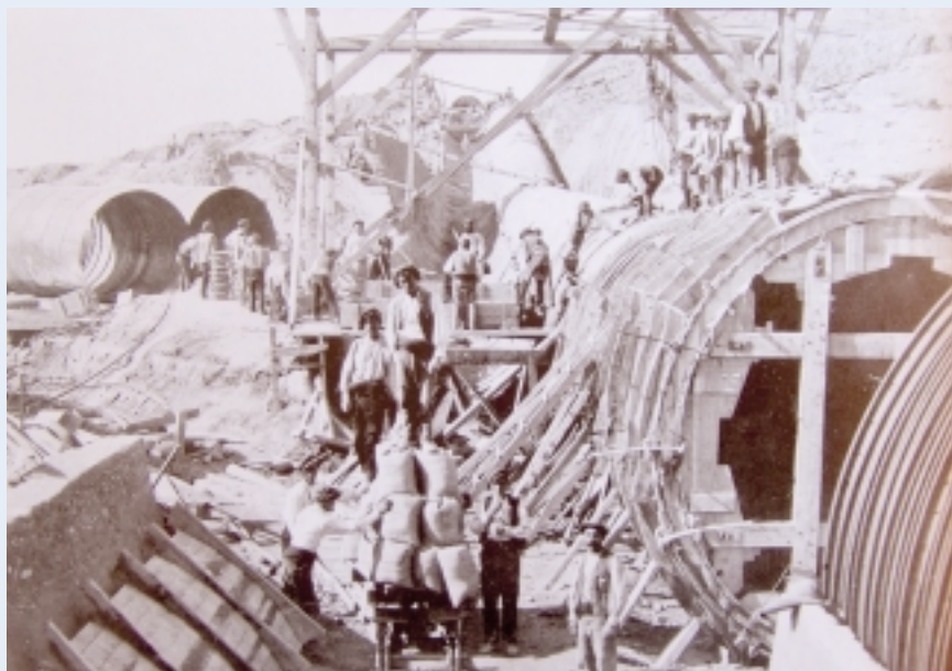
El sifón del Sosa en plena construcción
