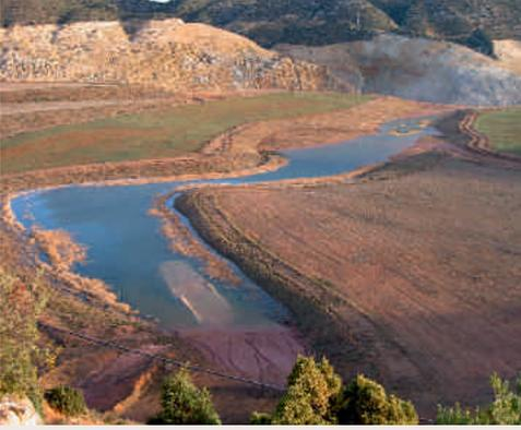
Plataformas revegetadas y humedal generado en el hueco final, resultado de la restauración de los terrenos de la corta Barrabasa
