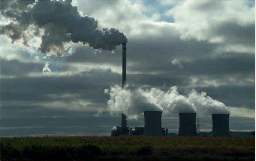
El elemento común a los tres grupos que más destaca es la chimenea de salida de gases, con 343 metros de altura, 28 metros de diámetro en la base y 12 en la coronación.
