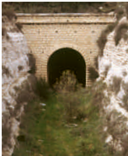
Valmadrid. Túnel de Valdescalera, al servicio de la antigua vía del FFCC de Utrillas cuyo trazado en desuso merecería convertirse en “Vía Verde”
