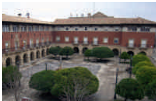
Vista de la plaza mayor de Belchite, con el Ayuntamiento
