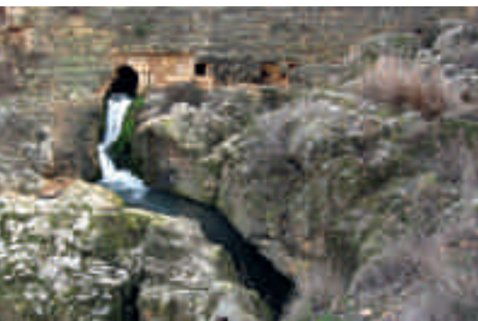
Almonacid de la Cuba. El “Ojo”, aliviadero abierto en el siglo XVIII a través de la presa romana, origen de la “Acequia Madre” de Belchite
