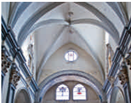
Interior. Bóveda original de crucería sencilla y pilastras barrocas
