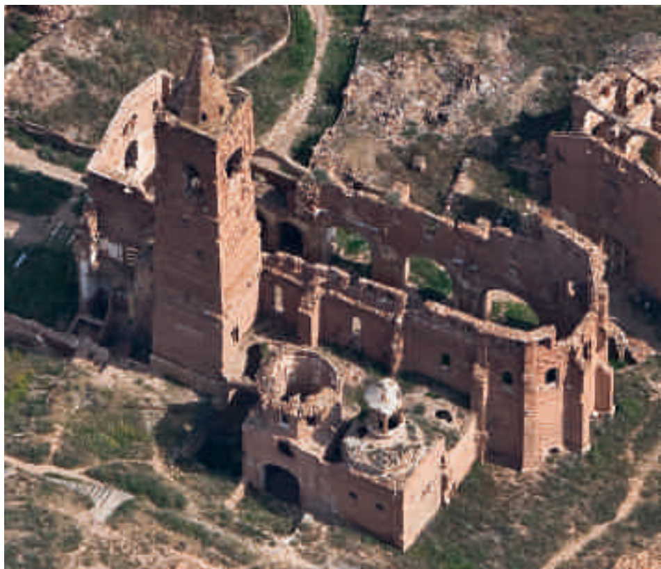
Vista aérea de la iglesia de San Martín de Tours
