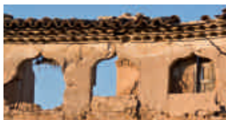
Belchite. Alero de tejas sobre mirador de arcos conopiales
