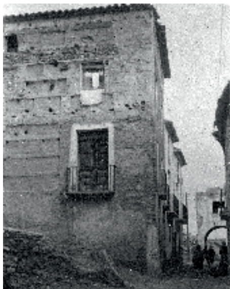
Vivienda tradicional de Codo construida en tapial
