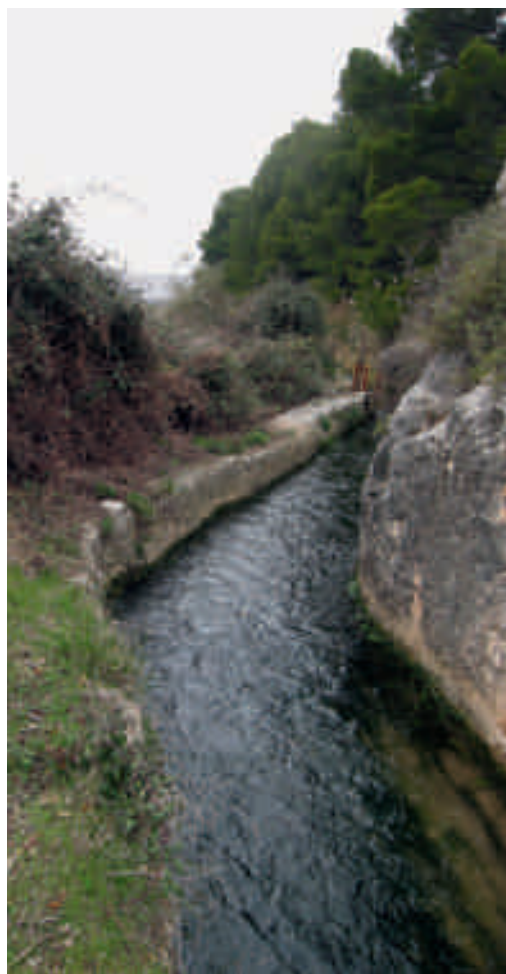
La Acequia Madre de Belchite en el estrecho llamado de Malpasillo, excavada en la roca
