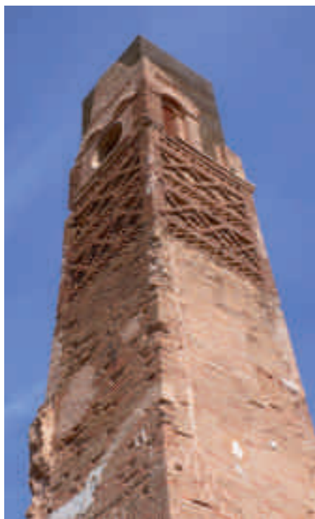
Torre del Reloj, recientemente consolidada
