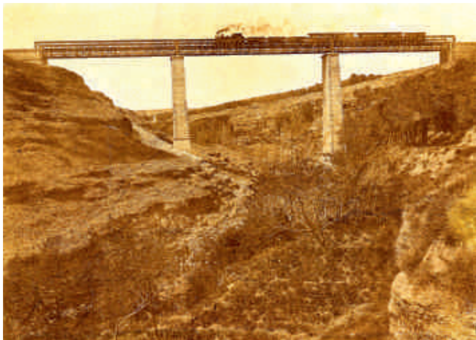
Belchite, partida del Amutel. Viaducto del ferrocarril Zaragoza-Utrillas sobre el río Aguasvivas, de 115,50 m de longitud por 36 m de alto (principios del siglo XX)
