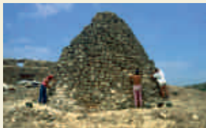
Trabajos de consolidación de la “Nevera del Calvario” (13-VIII-98)
