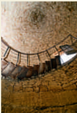
Nevera de la Culroya. Interior, con el pozo excavado en la cantera, la moderna escalera y la cubierta de falsa cúpula por aproximación de hiladas
