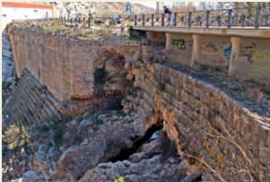
El estribo izquierdo de la presa revestido de opus quadratum rústico a mediados del s. I d. C. y perforado por el aliviadero del siglo XVIII. Sobre la corona de la presa la carretera actual de acceso a Almonacid de la Cuba.
