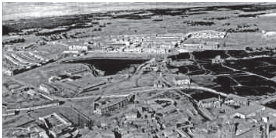
Vista aérea con los dos Belchites: el pueblo viejo todavía habitado (abajo, zona de la Puerta de la Villa y convento de San Agustín) y, al fondo, el pueblo nuevo en fase de construcción (hacia 1950)
