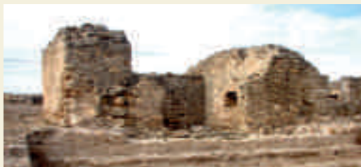
Torreón central del costado oeste, desde el interior
