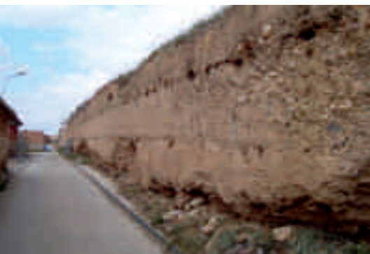
Azuara. Muralla de tierra de época medieval, tramo del Ferial
