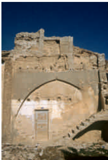
La Puebla de Alabortón. Secular arquitectura tradicional de adobe y tapial
