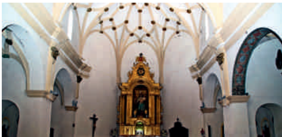
Almonacid de la Cuba. Interior de la parroquial, con la bóveda de cruceira y el entablamiento de la reforma barroca
