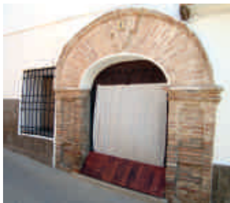
Azuara. Empleo de ladrillo en la rosca de los arcos
