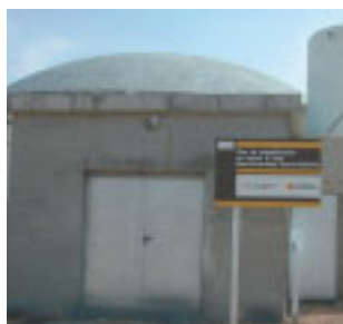
Depósito. Moyuela. Campo de Belchite
