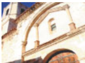
Rehabilitación Iglesia Castel de Cabra. Cuencas Mineras
