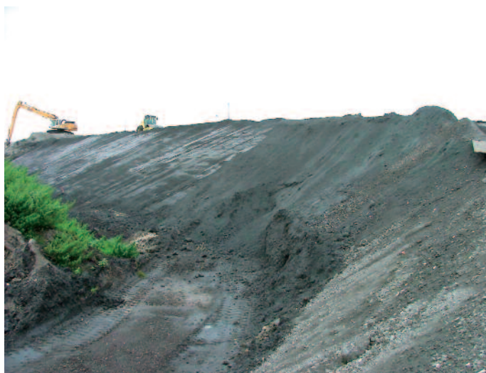
Obra civil con ceniza volante de carbón (2005)
