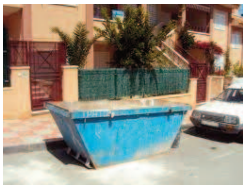
Ejemplo de contenedores de RCD en obras.
