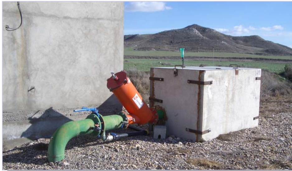
Foto(3): Cabezal de entrada sin válvula maestra
