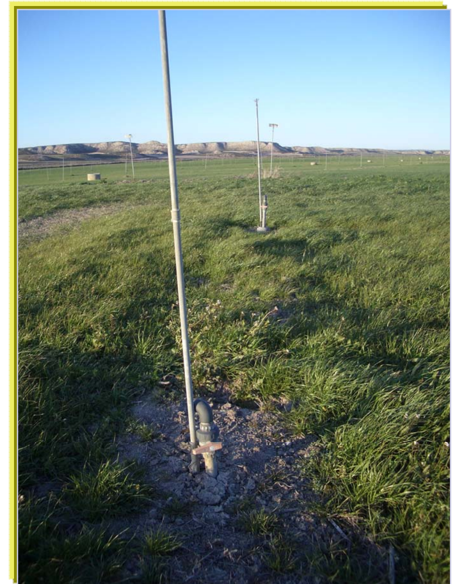
Foto (5): Desagües sector
