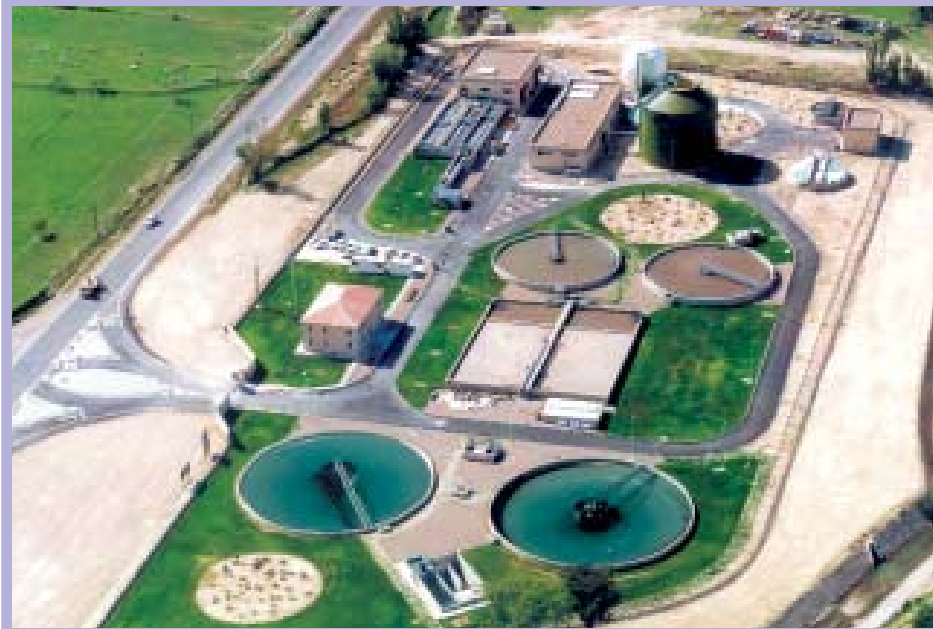
Vista aérea de la depuradora de Huesca.
