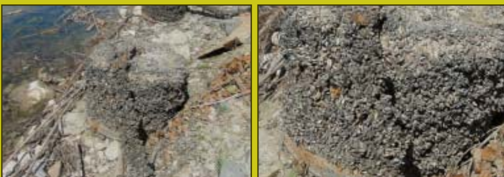
Mejillones cebra adheridos a infraestructuras en el embalse de Ribarroja. (Fotografías: Manuel Alcántara)
