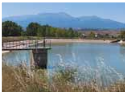
Figura 6: Embalse de Santa Ana que regula la Acequia Magallón Grande de la Comunidad de Regantes de Tarazona.
